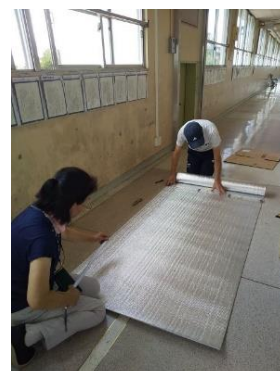
断熱シートを窓の大きさにカット
