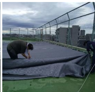
2m幅の遮光ネット同士をロープで固定
