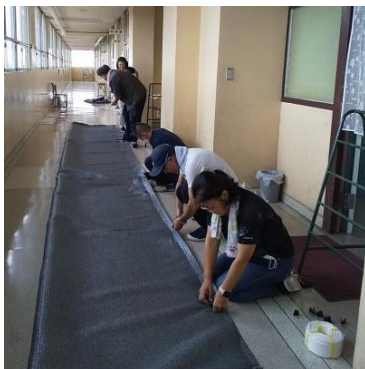
遮光ネットにロープを通すクリップを30cm間隔で装着
