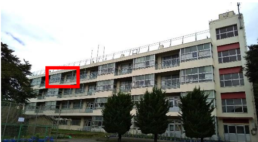
北校舎を南側から撮影した写真 (赤く囲んだ教室が6年3組)
